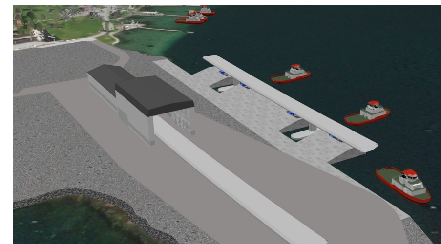
Figur 8-4 Ferdig brukasse skyves ut av hallen, monteres på pontong ved hjelp av multiwheelere
