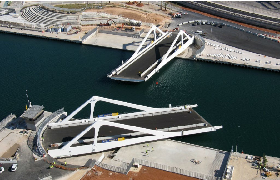
Figur 3-5 Bevegelige bruer i Valencias havn, samme overbygning som klaffebru og svingbru
